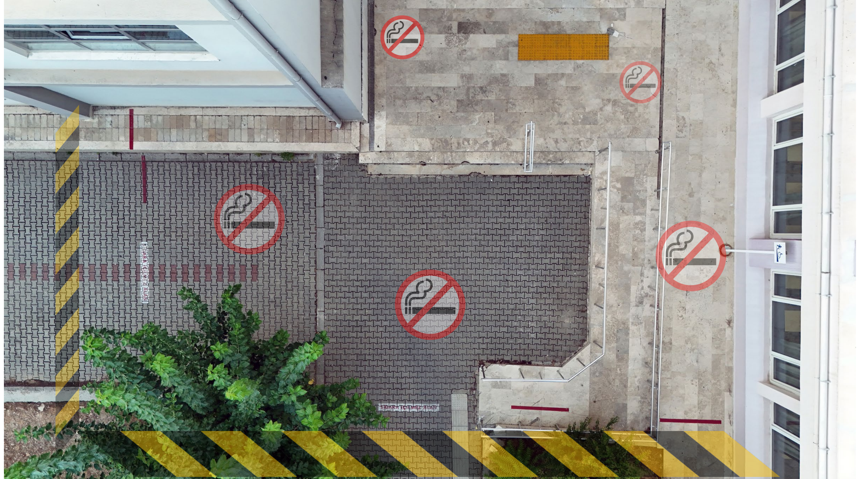
İdari Bina Giriş Kapısı
